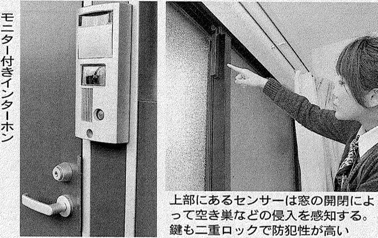
窓の開閉などを感じるセンサーの起動や解除をするコントロール。右はモニター付きインターホン=いずれも岡山市
